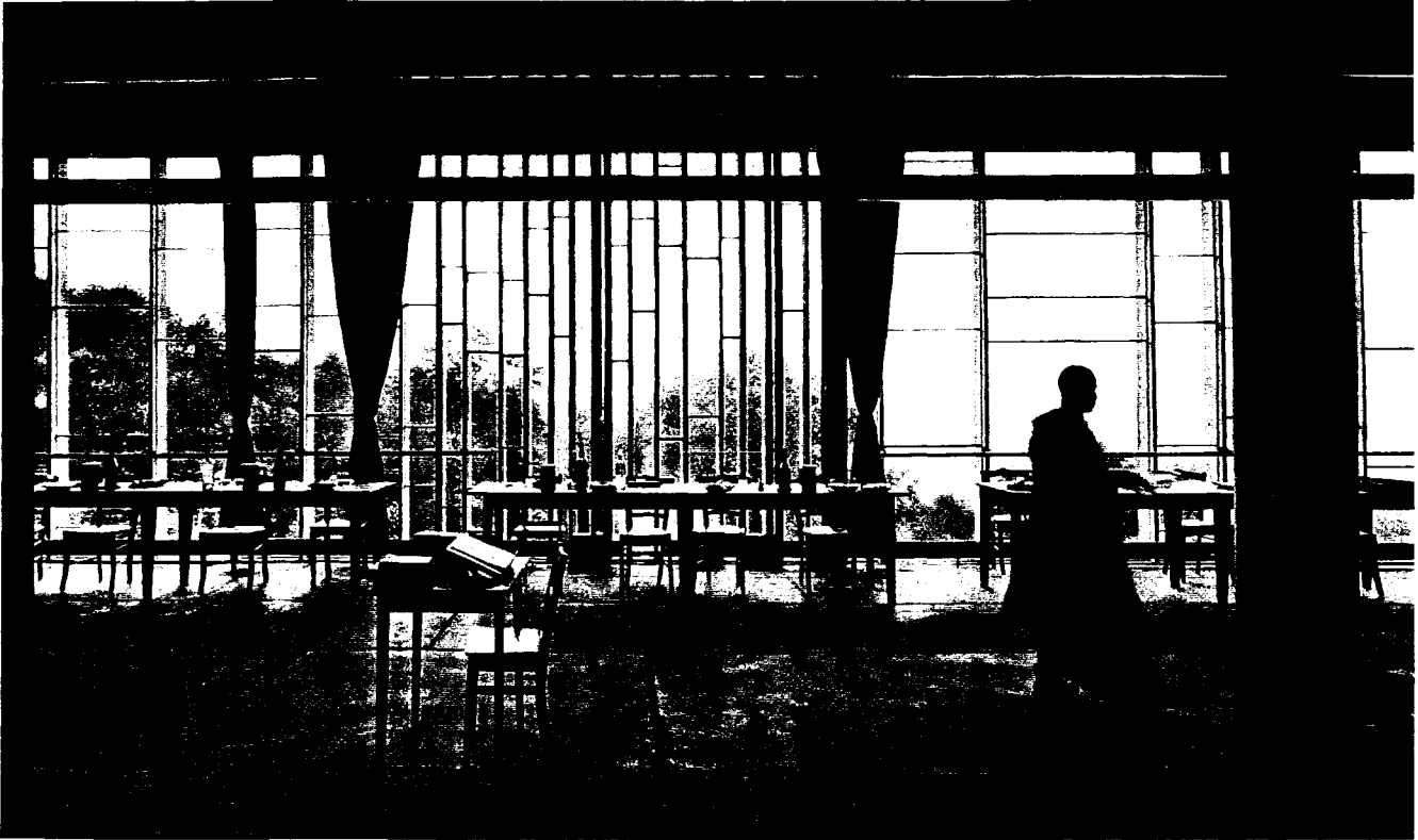
Fig. 7. Le Corbusier, Couvent de la Tourette, interior of refectory with pan de verre ondulatoire ; two (open) aerateurs are visible (Oeuvre complète, 1957-1965, p. 44).
