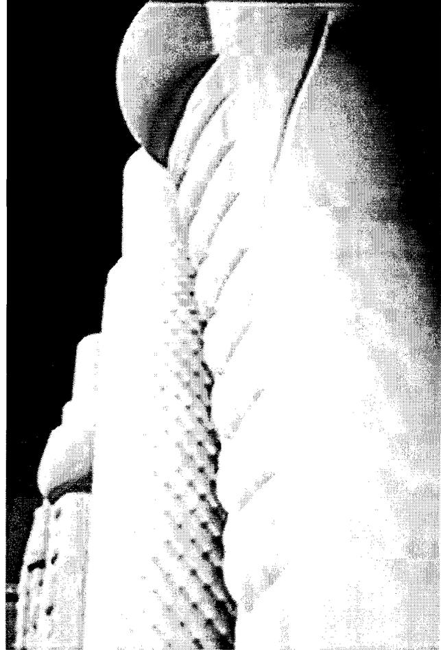
Fig. 2. Fabric-formed columns
